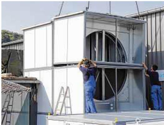
Technik zur optimalen Nutzung der Energie: der Rotationswärmetauscher für das Tiengener Möbelhaus.
