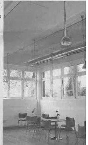
Be- und Entlüftungsanlage mit Rundrohr aus dem Aufenthaltsraum des Showrooms bei S
